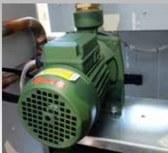
Pompa di circolazione - Circulating pump
